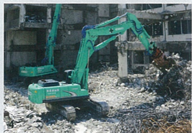
入社4年目のオペレータ 田中智之さんは、専用ニブラを装着した20t機で大きなコンクリートがらの小割を担当
