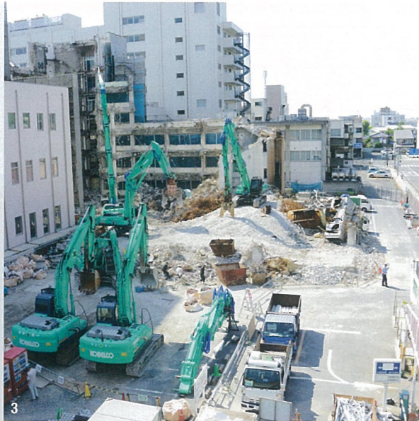
入社4年目のオペレータ 田中智之さんは、専用ニブラを装着した20t機で大きなコンクリートがらの小割を担当
