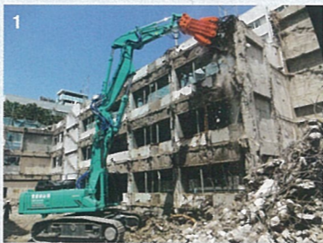
入社4年目のオペレータ 田中智之さんは、専用ニブラを装着した20t機で大きなコンクリートがらの小割を担当
