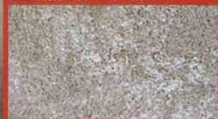
B.剥離剤除去の場合 細かな凹みに残る仕上塗材
