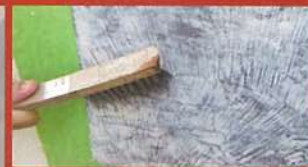
A.剥離剤除去の場合 仕上塗材除去後ネバネバ残り
